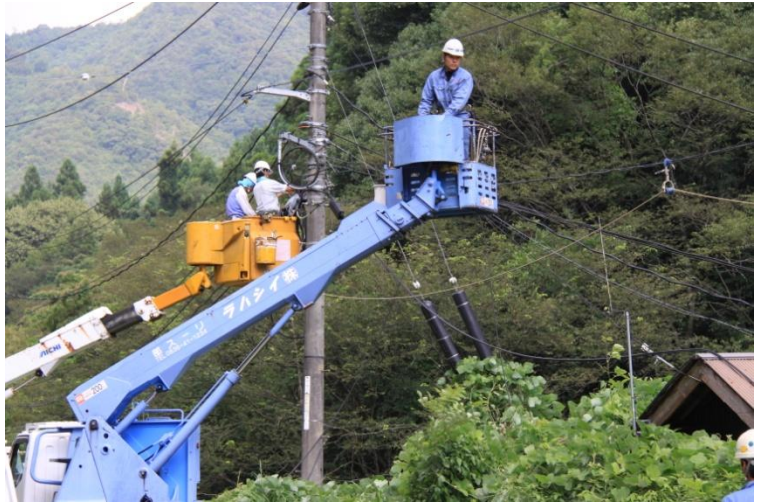
小川～弥富間60芯約400mのケーブル張替え
