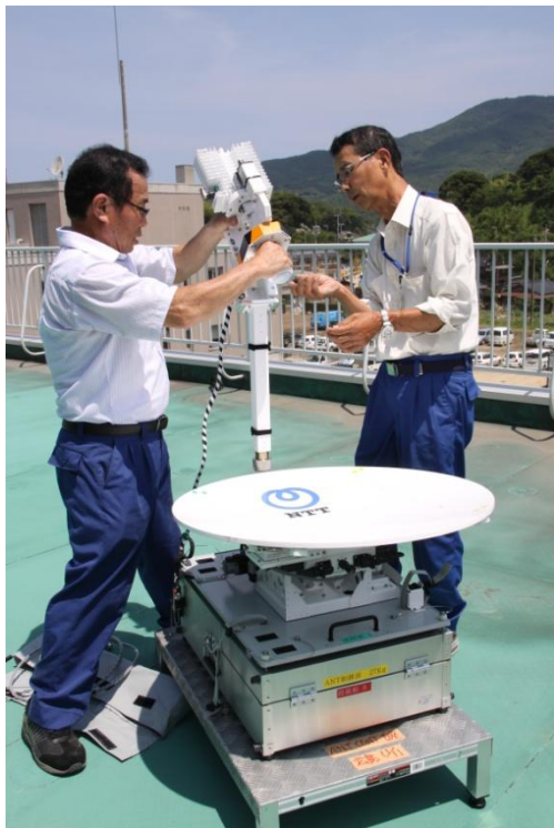
須佐公民館へポータブル衛星システム(1台)設置
