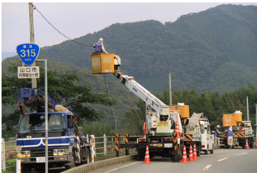
徳佐～生雲間2中継光ケーブル40芯張替え(仮設)
