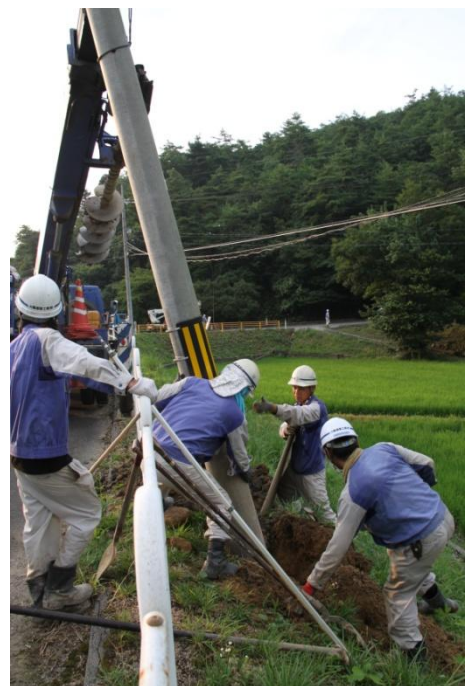
徳佐～生雲間 電柱建柱(仮設)
