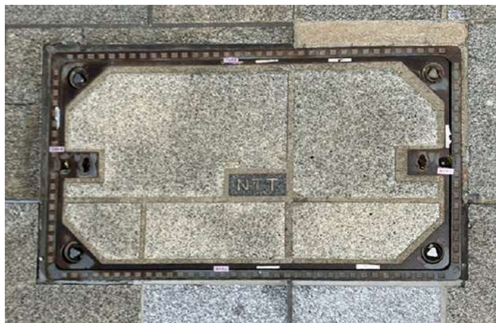
封印シールを張り付けたマンホール
