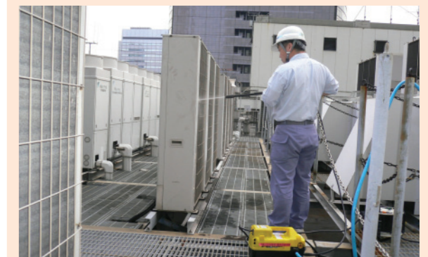
空調設備のフィルターを洗浄
