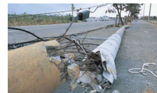
台風により倒壊した電柱
