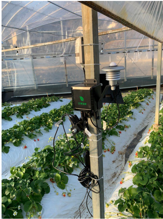
ICT センサー設置の様子
