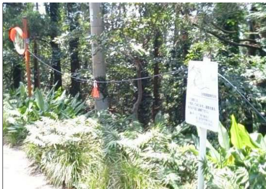
※通信ケーブルの敷設①（本村～田代間）
