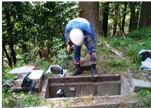
※通信ケーブルの敷設②（本村～田代間）
