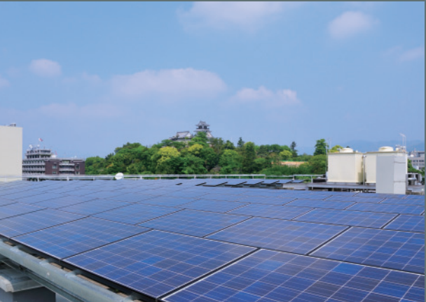
NTT高知支店ビル 屋上の太陽光発電システム
