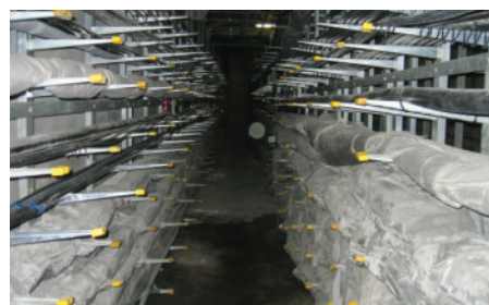
とう道 (通信ケーブル用地下トンネル) 245km
