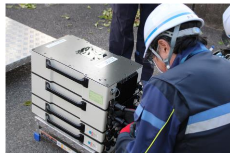
電源設備等組み立て
