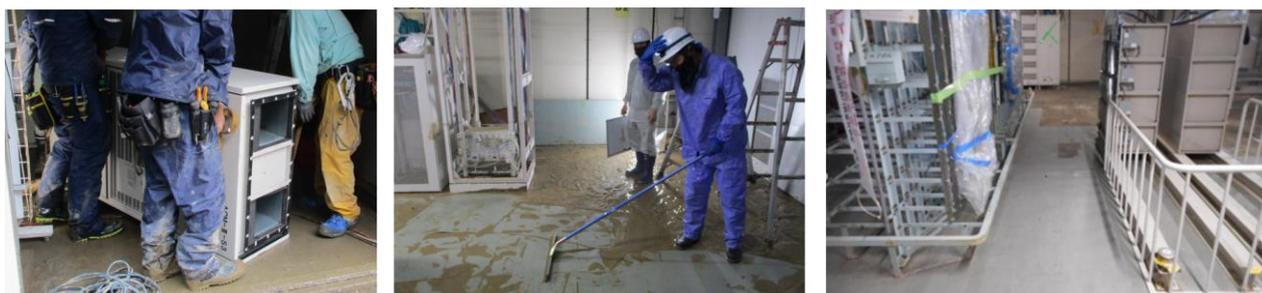
NTT坂本ビル(熊本県八代市)の復旧作業模様:浸水等による故障装置の撤去、ビル内の高圧清掃・消毒・乾燥作業
