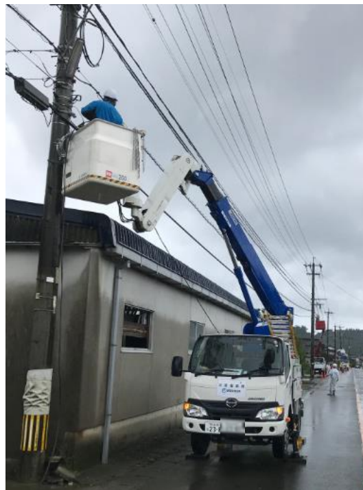
【熊本県での通信ビル間の中継ケーブルの復旧作業】
