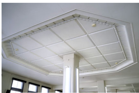
建設当時のまま残っている漆喰の天井装飾
