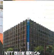
NTT西日本 桜町ビル
