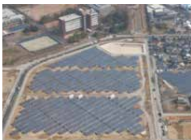
F鈴鹿太陽光発電所
