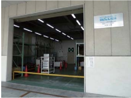
図2 バッテリー再生大阪工場
