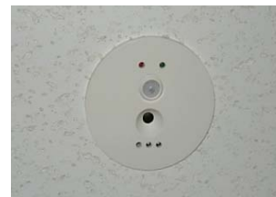
図3 人感・照度センサーの外観
