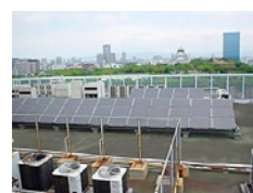
NTT西日本馬場町ビル 屋上のソーラーシステム
