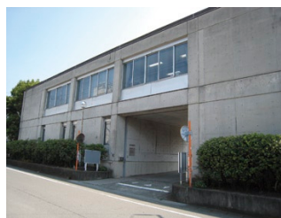
写真 1 PCセキュリティリサイクルセンタ
