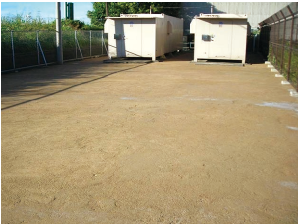
写真1 RT-BOXの「土舗装」
