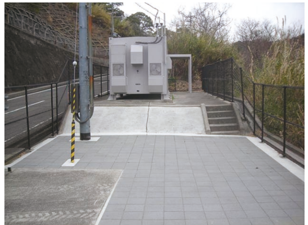
写真2 RT-BOXの「CPブロック舗装」
