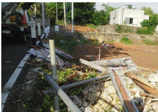
※倒壊した電柱の撤去作業（沖永良部）
