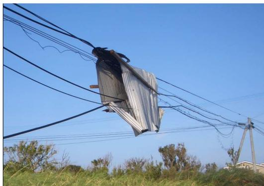
※飛来物によるケーブルの損傷（与論）
