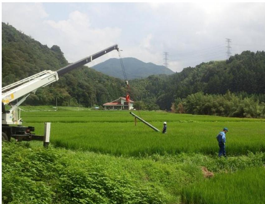
倒壊した電柱を田んぼから撤去
