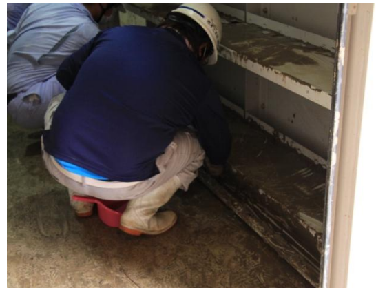
水没した交換所での洗浄作業
