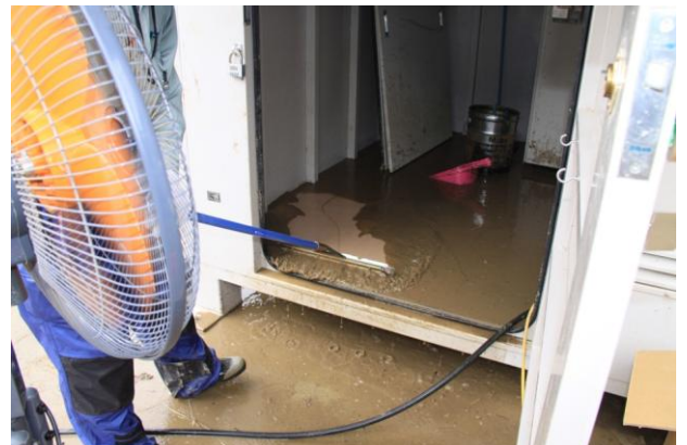
水没した交換所での洗浄作業
