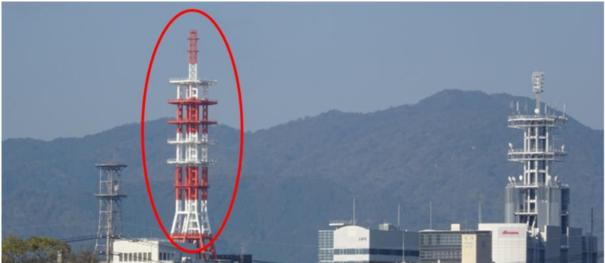
写真：撤去対象の鉄塔（赤色枠内）
