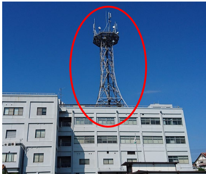
写真：塗装替え対象の鉄塔（赤色枠内）
