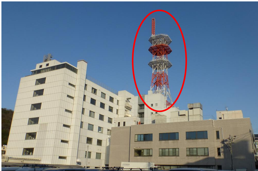
写真：撤去対象の鉄塔（赤色枠内）
