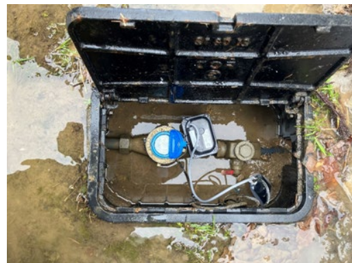
水道メーターへの接続イメージ
