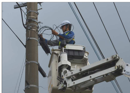
※一軒一軒の故障修理（南さつま市）9/4
