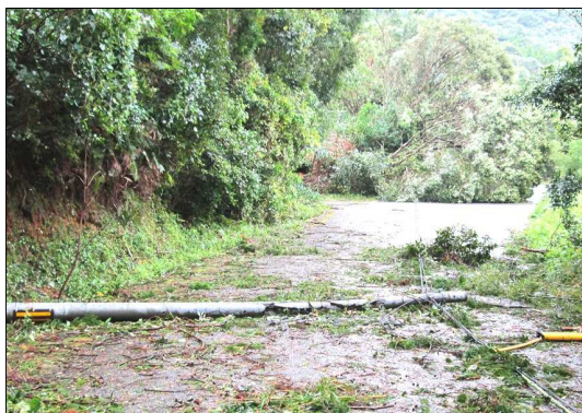
※倒壊した電話柱（南さつま市）8/25
