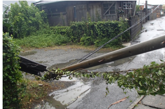
※電柱の倒壊（大島郡龍郷町）8/7
