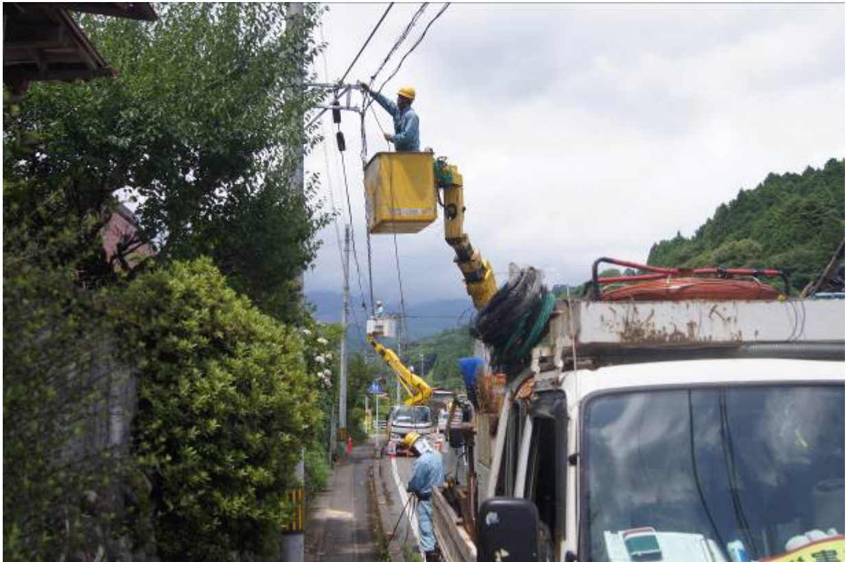
【通信ケーブル復旧作業模様】
