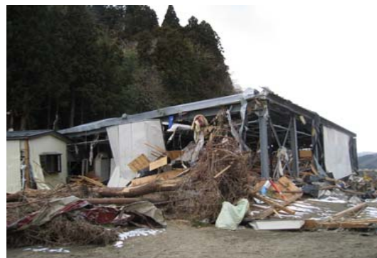
《宮城県 北上ビル》
