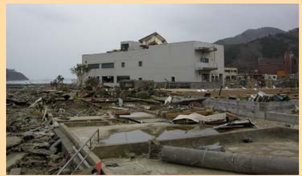
津波により周辺が水没し交換機収容ビルが大きく損壊
