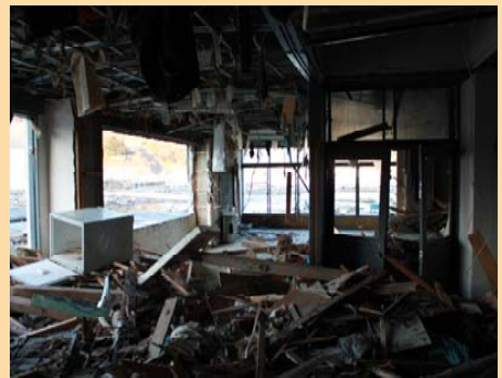
ビル壁が崩壊し内部にも大量の漂流物
