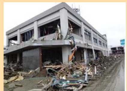
津波により周辺が水没し交換機収容ビルが大きく損壊
