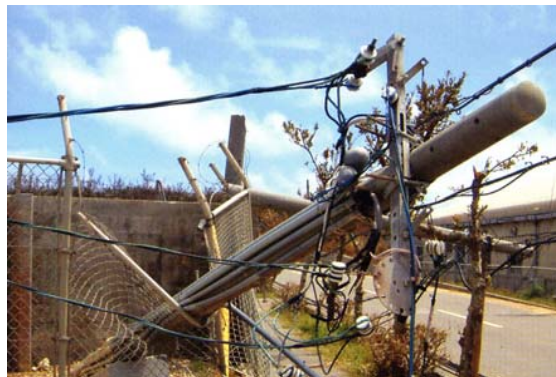
大型台風の来襲時には予め保守要員を待機させ、被害を受けた電話ケーブルを復旧する
