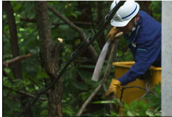
夏は下枝を払い、草を刈り、冬は深い雪を踏み分けて、電話ケーブルの保守を行う
