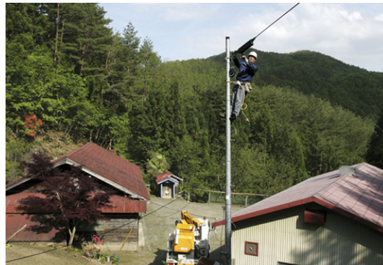
高所作業車が届かない場所での故障修理も多い
