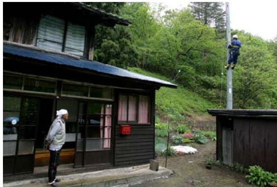
雨の多い季節には故障の発生が多く、故障箇所の特定に辛く厳しい雨中の作業が避けられない
