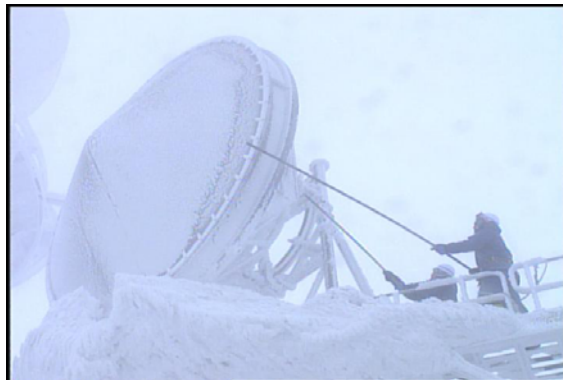
山上にある無線中継アンテナにこびりついた雪をそぎ落とし、通信を確保
