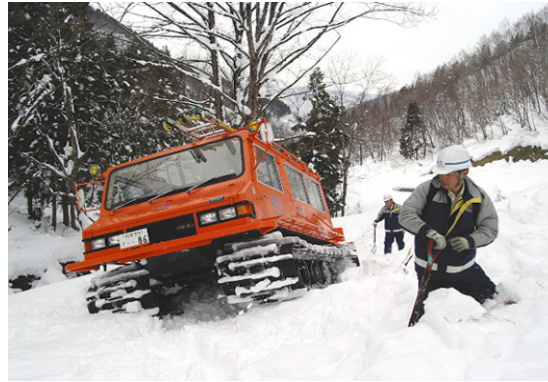
雪崩により裂断された電話ケーブルを復旧させるため、雪上車で山奥の現場に向かう
