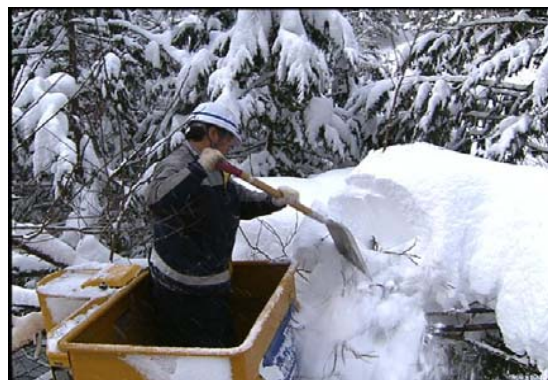
雪が電話ケーブルを巻き込んで切断させたり、たるませる被害を防止するため、高所での雪かきを行う
