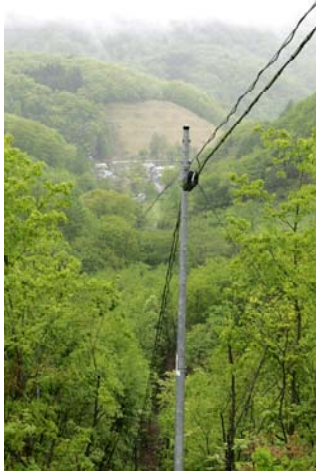
山を越えてつながる電話ケーブルのメンテナンスは重労働
