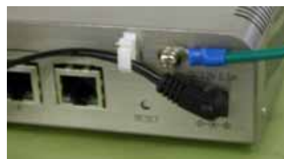
③電源コード取り付け状態
