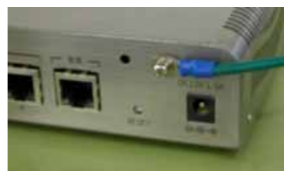
①FG ケーブル取り付け状態
