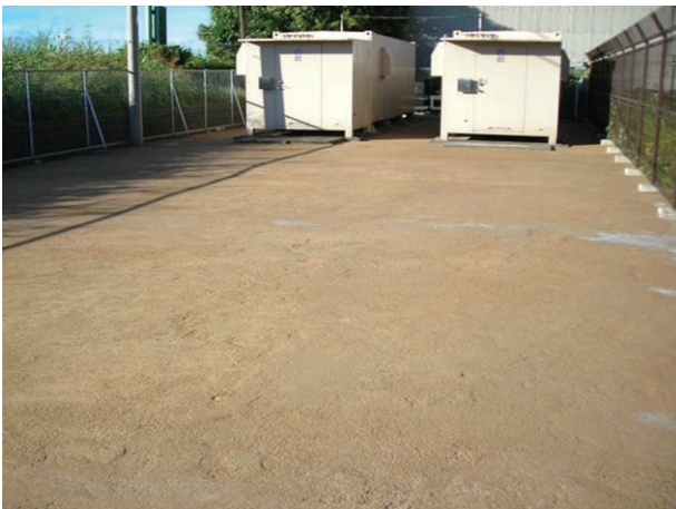
写真1 RT-BOXの「土舗装」
