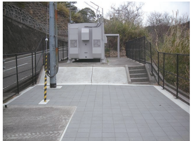
写真2 RT-BOXの「CPブロック舗装」
