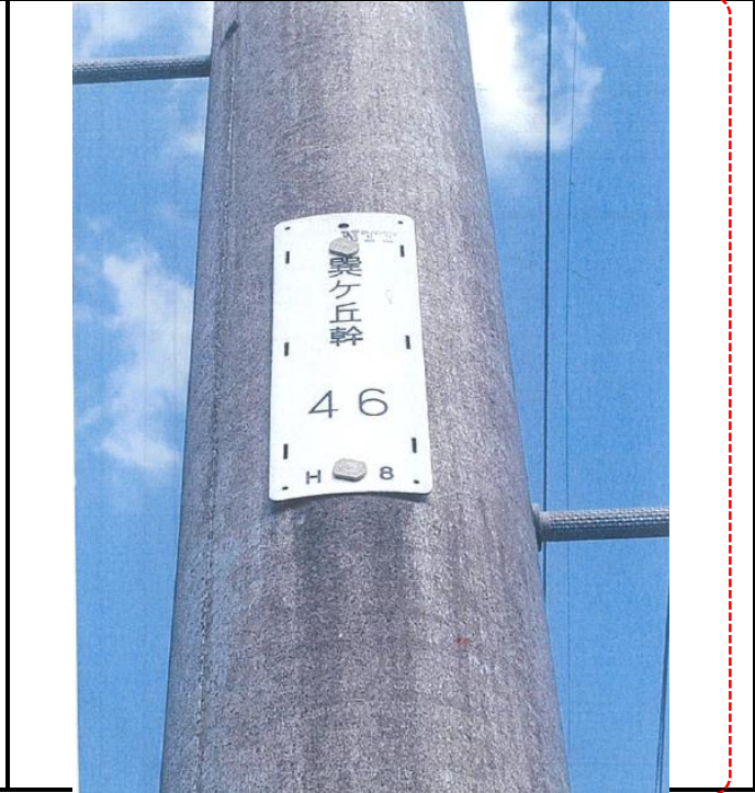
(工事前電柱札写真)
